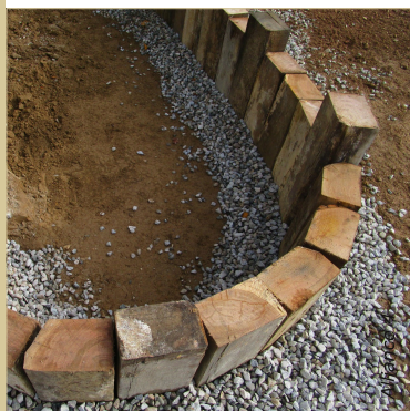
Une fois les traverses mises en place, commencer le remplissage en terre végétale. Mettre en place les graviers au fur et à mesure du remplissage.
