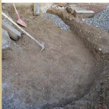
Décaisser pour enfoncer les bois sur un tiers de leur hauteur.
