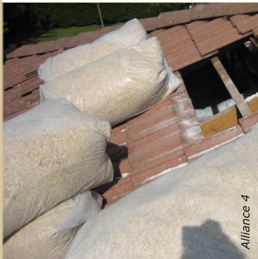
Une fois mélangé, le chanvre stabilisé est remis en sac pour faciliter la manutention.
