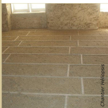
Dans ce grenier, un contre solivage en planches a été mis en place. Un plancher sera fixé dessus.
