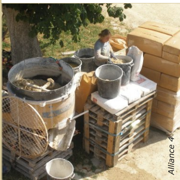
La stabilisation du chanvre se réalise facilement et rapidement dans des malaxeurs.
