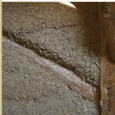
Le béton de chanvre est mis en place dans un colombage.
