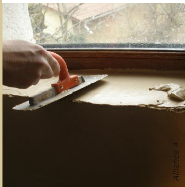
L'application des enduits de finition est un poste clé dont le succès dépend de quelques règles d'exécution.
