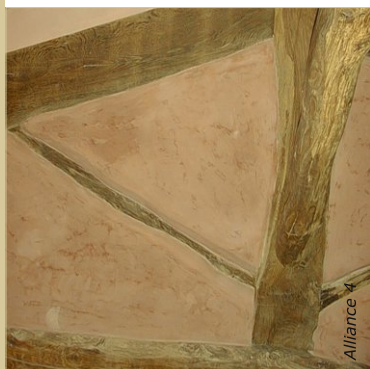
Après séchage complet du béton de chanvre, on applique un corps d'enduit à la chaux aérienne. Ici, un enduit de finition a été appliqué sur le corps d'enduit sec.
