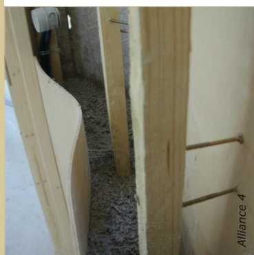
Des planches de coffrage cintrables permettent de créer des arrondis. Les possibilités architecturales sont infinies.
