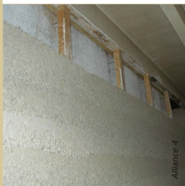
La face arrière de la cloison est coffrée entièrement. Les banches sont déplacées sur la face avant.
