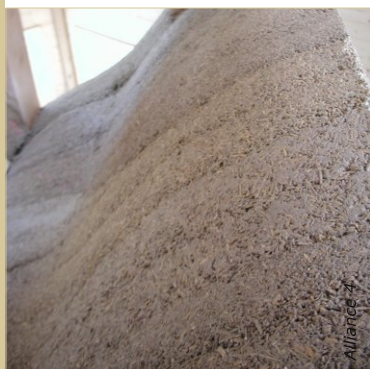
Des planches de coffrage souples permettent d'obtenir des cloisons arrondies.
