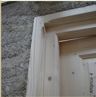
Les cadres des portes sont intégrés dans la matière. Les enduits viennent parfaire l'étanchéité aux sons.
