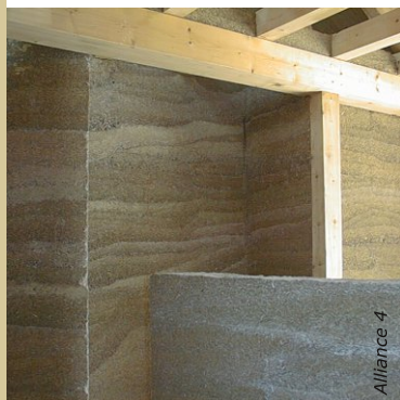
Cloison et muret de séparation brut de décoffrage, prêts à être enduits.
