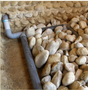
Les grosses pierres sont mises en place côte à côte, puis les plus petites dessus. Les graviers sont à éviter car ils risquent d'étouffer le hérisson.
