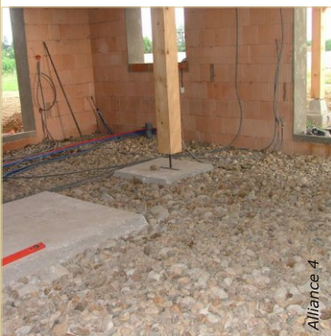
Les cailloux de la deuxième couche sont plus fins mais doivent rester grossiers. Il faut éviter que les pierres plus petites viennent boucher les espaces entre les grosses.
