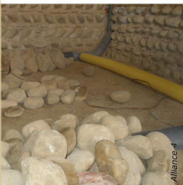
La sortie d'air remonte dans le soubassement. Les entrées et sorties sont en tuyaux pleins.
