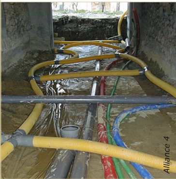
Mise en place du réseau de drain d'air (en jaune). Les autres canalisations de l'habitation passent également dans le hérisson.
