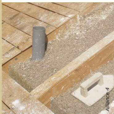
La sortie du drain d'air apparaît en toiture. Cette colonne montante va créer un tirage, en statique, et garantir la circulation d'air dans le hérisson de pierre. Cette ventilation va assécher et assainir l'espace sous la dalle.
