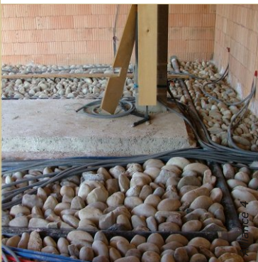
Les socles et semelles porteuses sont coulées avant la pose du hérisson. Les gaines électriques sont posées sur le hérisson.
