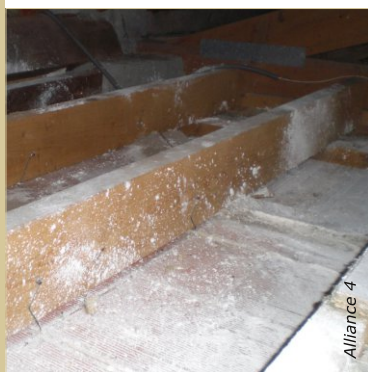
Le plafond suspendu en briques est un excellent parement intérieur. De la chaux aérienne est saupoudrée dans le fond du caisson. Ce chaulage est assainissant. Il fait fuir les parasites et détruit les moisissures.
