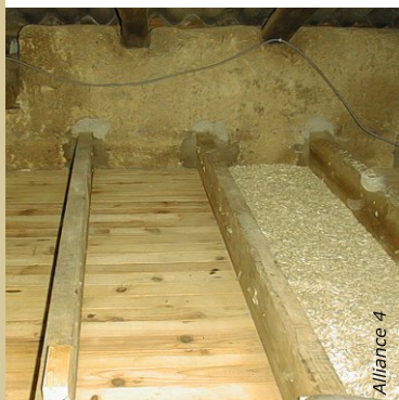
Nettoyer les caissons et protéger les supports bois avec une couche de chènevotte sèche (2 cm) puis saupoudrer de la chaux aérienne dessus.
