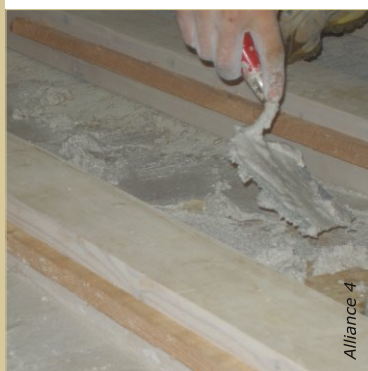
Renforcement de l'étanchéité à l'air sur un lambris, par l'application d'une fine couche de plâtre.
