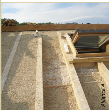
Soigner le tassage dans les recoins pour une bonne efficacité du montage.
