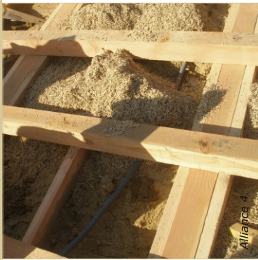
Déverser une première couche d'isolant puis la tasser. Soigner le remplissage sous les chevrons.
