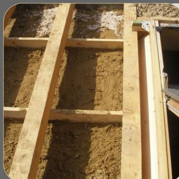
**8.** Le mortier sert d'étanchéité à l'air et remplace le frein vapeur. Il épouse les contours des pièces de bois et permet d'obtenir un parement continu.
