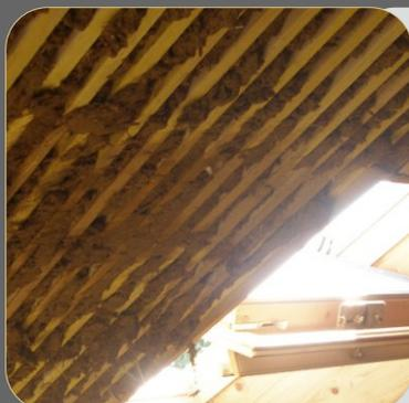
**7.** Il est possible de travailler avec un mortier extrêmement fibré, de type torchis.
