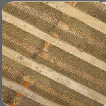
**6.** Déposer le mortier sur le dessus des lattes et le répartir généreusement sur toute la zone et dans tous les recoins.
