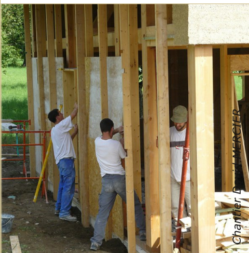
Mise en place du coffrage avec le système d'ossature extérieure.
