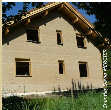
Maison réalisée en structure poteaux-poutres, remplissage des murs en béton de chanvre.
