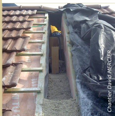
Le haut du mur est banché à partir d'un accès sur le toit. La jonction entre les bétons de chanvre de la toiture et des murs est continue.
