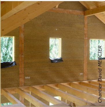
L'ossature peut être visible sur une façade.
