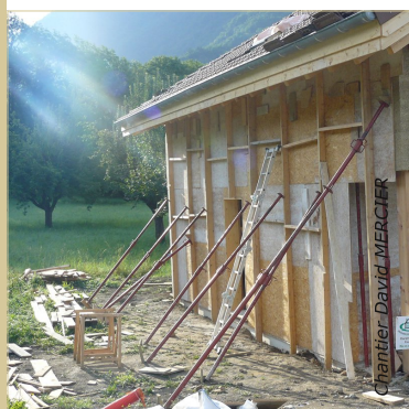
La face extérieure du mur est coffrée entièrement. Les banches intérieures sont déplacées au fur et à mesure du remplissage.
