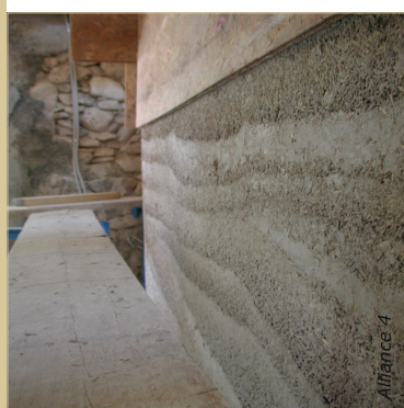
Le remplissage se réalise par lits successifs de 15 cm maximum. L'aspect des strates doit être régulier.
