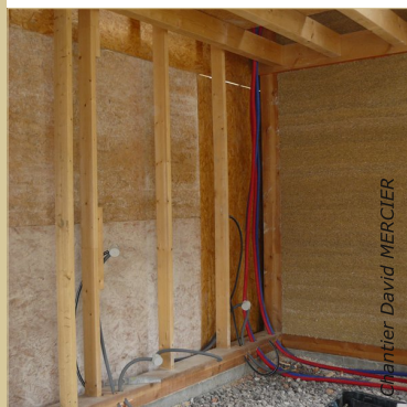
Tous les réseaux techniques sont noyés dans le béton de chanvre.
