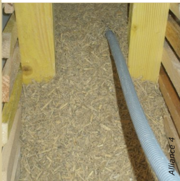
Le réseau électrique est positionné, le plus loin possible des habitants, du côté extérieur.
