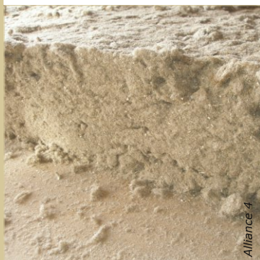
La ouate de chanvre se met en place par couches successives tassées. Le matériau forme alors un manteau parfaitement homogène.
