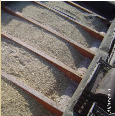
Nettoyer l'espace à remplir. Ici, le remplissage entre paroi est fait lors de la mise en place de l'isolation des combles, en chanvre stabilisé également.
